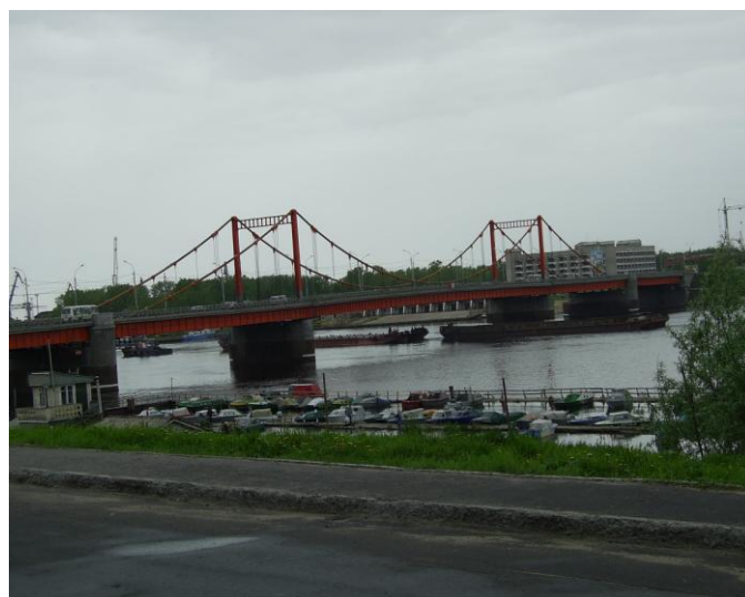
Мост через Кузнечиху
